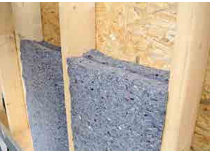
Dämmung mittels Baumwollmatten in einer Holzständerkonstruktion – analog wäre bei einer Zwischensparrendämmung zum Beispiel auch die Verwendung von Jutematten möglich
