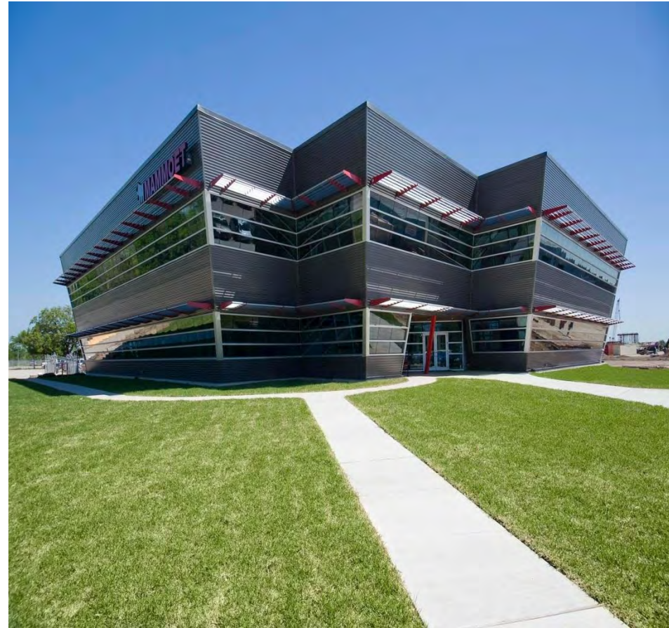
Mammoet USA HQ, Texas, USA
