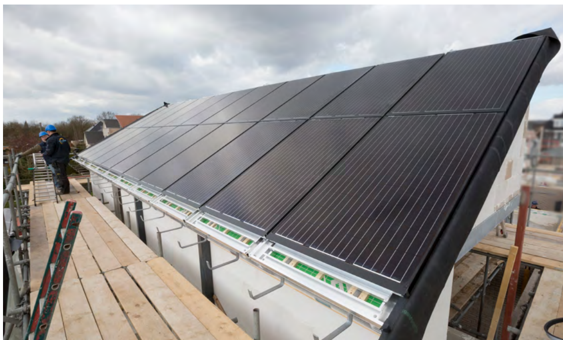
Unidek SolarPower: dakisolatie en energieopwekking in één PV-dakoplossing
